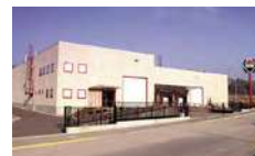
NOUVEAUX ENTREPÔTS RUBÍ, BARCELONE
