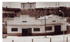
PREMIÈRE USINE RUBÍ, BARCELONE
