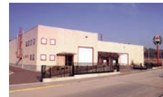
NOUVEAUX ENTREPÔTS RUBÍ, BARCELONE
